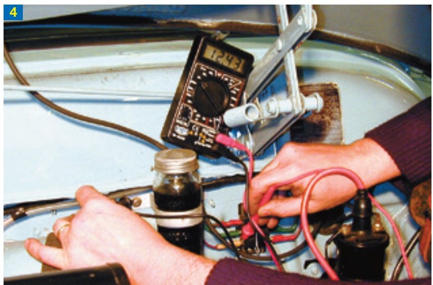
4 Prüfung des Stromeingangs an einer Sicherung: mit 12,43 V ist die Spannung in Ordnung.
